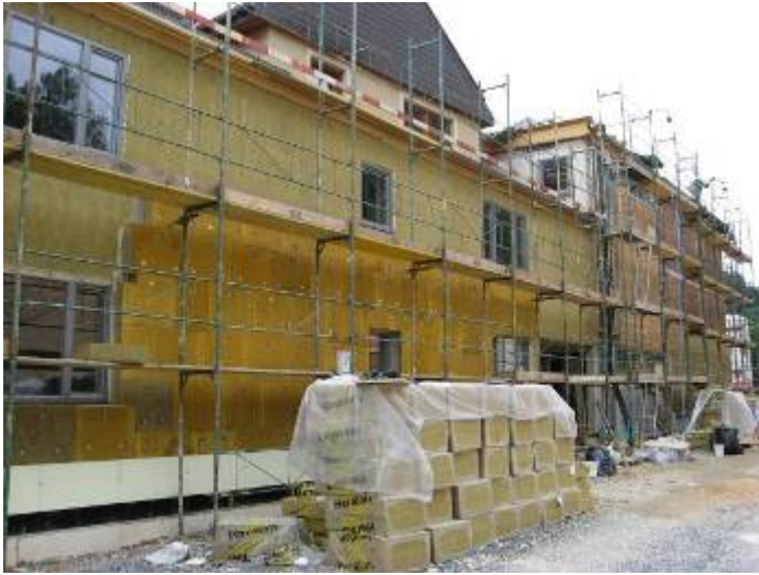
Figur 26. Utvändigt tilläggsisolering är en väldigt effektiv åtgärd, (Arch. Kaltenegger).
