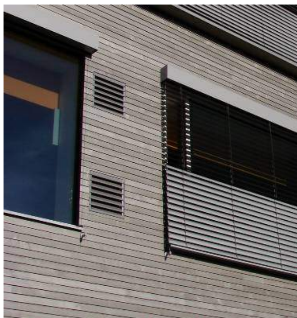
Figur 11. Två exempel på extern solavskärmning med utvändiga persienner. Vänstra figuren visar ljusstyrande persienner. Den övre delen av persiennerna leder dagsljus in i rummet (Referens: AEE INTEC).
