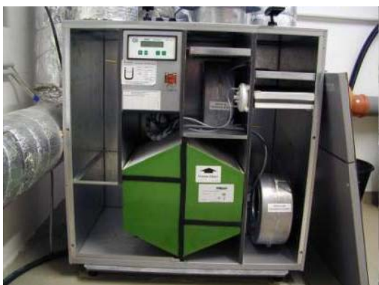
Figur 24. Ventilationsaggregat med integrerad värmeåtervinning och isolerade ventilationsrör (Referens: AIT; AEE INTEC).
