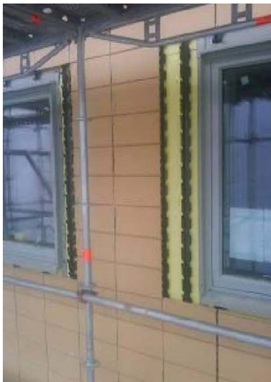
Figur 6. Utvändig tilläggsisolering och ny fasad i Brogården, Sverige (vänstra bilden) och tilläggsisolering på insidan av yttervägg, på grund av restriktioner för ändring av fasaden, i en historisk byggnad i San Juan de Malta, Spanien (Referenser: SP och TTA).
