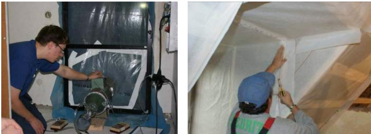
Figur 10. Lufttätetsprovning i pilotprojektet Brogården (vänstra bilden) och tätning av vind på Dieselweg Graz (Referenser: SP and AEE INTEC).
