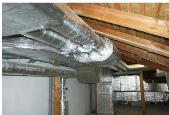
Figur 24. Ventilationsaggregat med integrerad värmeåtervinning och isolerade ventilationsrör (Referens: AIT; AEE INTEC).
