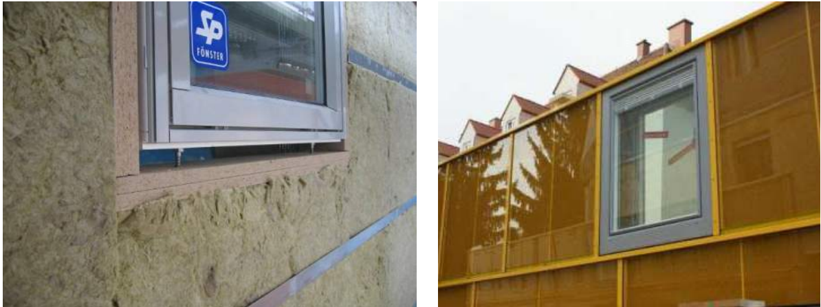
Figur 8. Treglasfönster med ett U-värde på 0,85 \text{ W/m}^2\text{K} , används i pilotprojektet Brogården/Sverige (vänstra bilden) och modulintegrerade passivhusfönster i Dieselweg Graz/Österrike (Referenser: SP and AEE INTEC).
