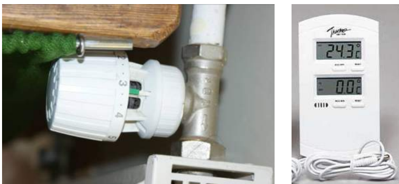
Figur 22. Termostatventil och utombustermometer (Referens: AEE INTEC; Star)
