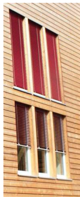
Figur 11. Två exempel på extern solavskärmning med utvändiga persienner. Vänstra figuren visar ljusstyrande persienner. Den övre delen av persiennerna leder dagsljus in i rummet (Referens: AEE INTEC).
