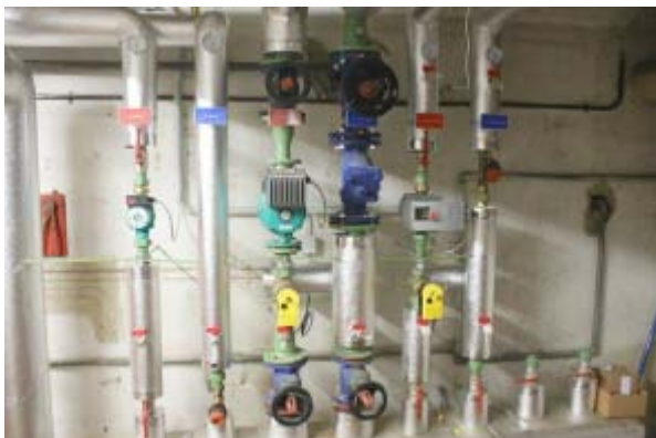
Figur 23. Värmedistribution och integrerat kontrollsystem; AEE INTEC.
