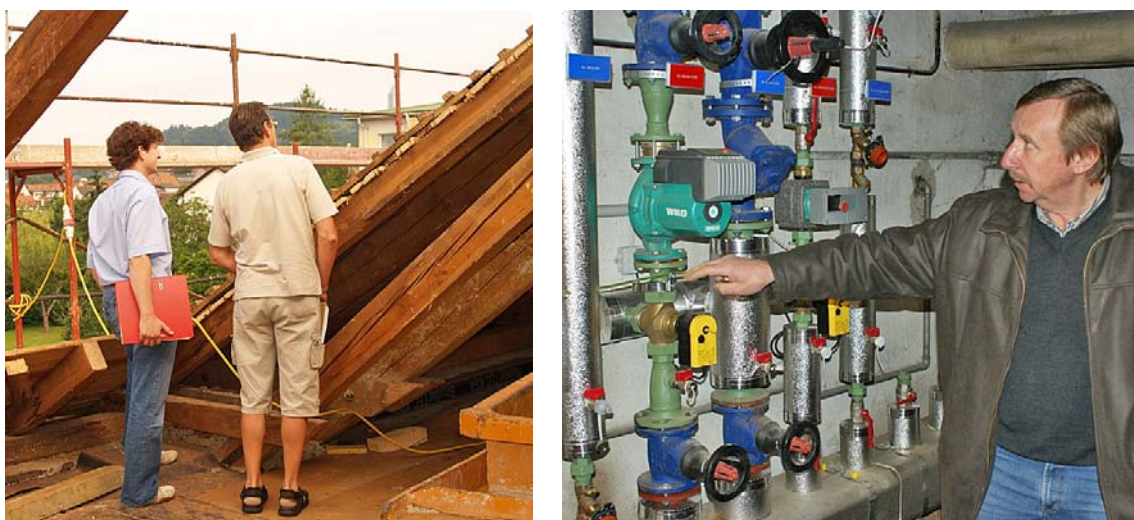
Figure 3.2 and 3.3 Inventering av byggnad och installationer
