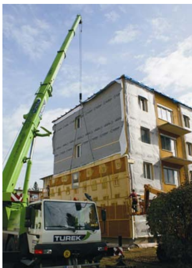
Figur 4.9 and 4.10 Bilder från renoveringen (vänster) – De prefabricerade transporterats till byggsplatsen på lastbil och lyfts på plats på fasaden med hjälp av en kran. Den högra bilden visar den nya fasaden med integrerade balkonger vilka ger en utökad boyta. Källa: AEE INTEC
