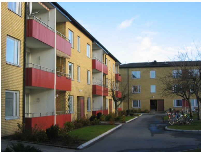
Figur 1 Det svenska pilot projektet Brogården före renovering.
