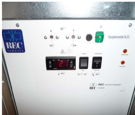
Figur 38 Ventilationsaggregat som installerats i varje lägenhet i hus D.
