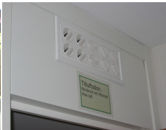
Figur 19 Skylten förklarar att detta är tilluftskanalen som tillför lägenheten uppvärmd och filtrerad friskluft.
