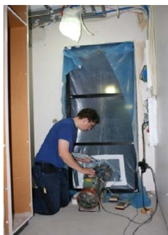
Figur 23 Byggnadsskalets täthet verifierades med hjälp av ett så kallat blower door test.
