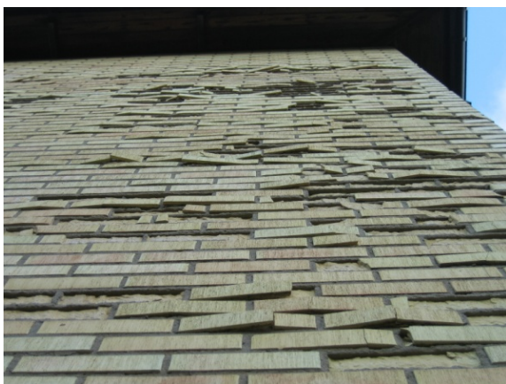
Figur 6 Tegelfasaden är frostskadad och måste tas ned.
