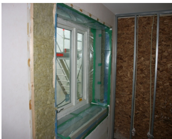
Figur 22 Ett exempel på en lufttät lösning på en fönsteröppning.
