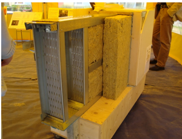
Figur 20 En prototyp byggdes av utfackningsväggen innan den uppfördes i fullskala.
