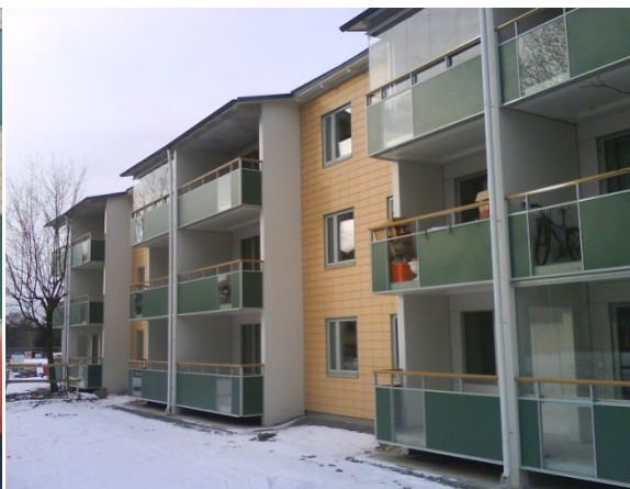
Figur 9 De vertikala färgade stråken behölls på balkongfronterna.
