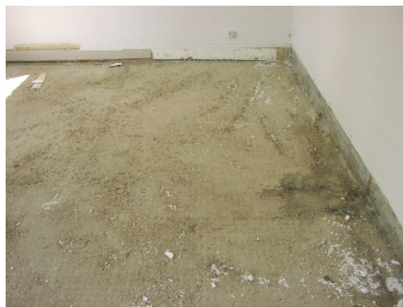
Figur 7 Betongplattan på mark har fuktproblem som måste åtgärdas.
