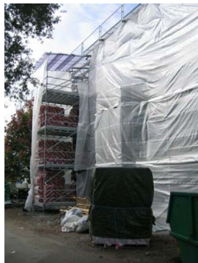
Figur 25 Byggentreprenören använde väderskydd för att få en torr byggsplats.
