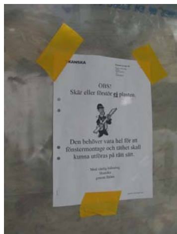
Byggnadsarbetarna påminns överallt om vikten av att klimatskärmen förblir tät.
