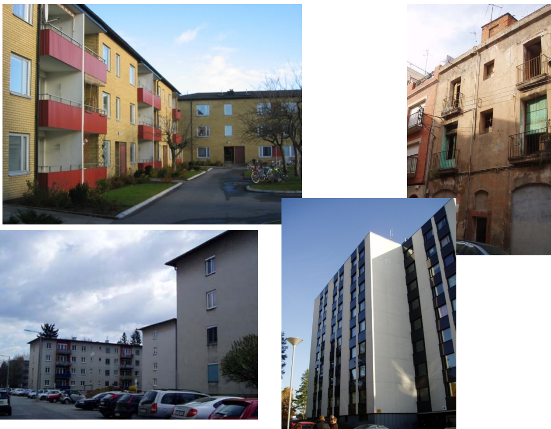
Figur 1. Byggnaderna i pilotprojekten före renovering (Brogården, Barcelona, Finland och Graz, medurs ordning)
